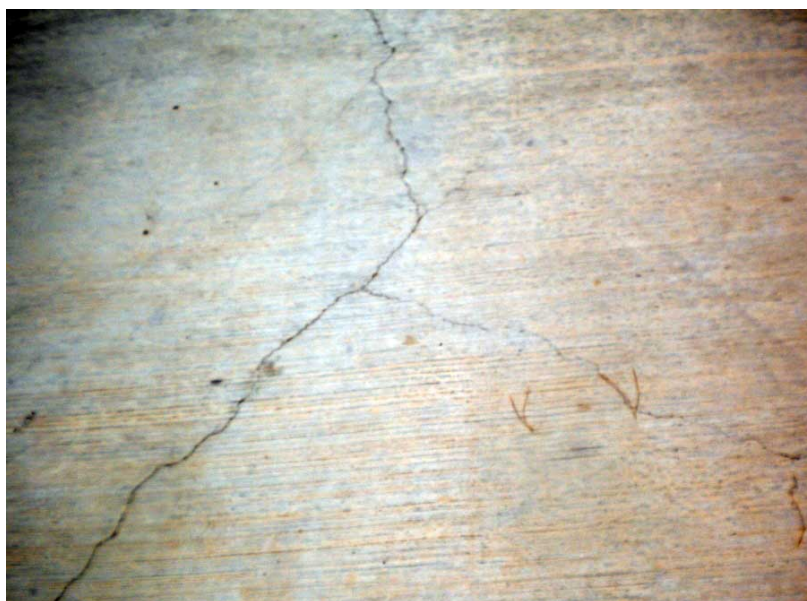
شکل ۱۳- در دال B27 ترکهای به هم پیوسته گسترش یافته مشاهده می گردد
