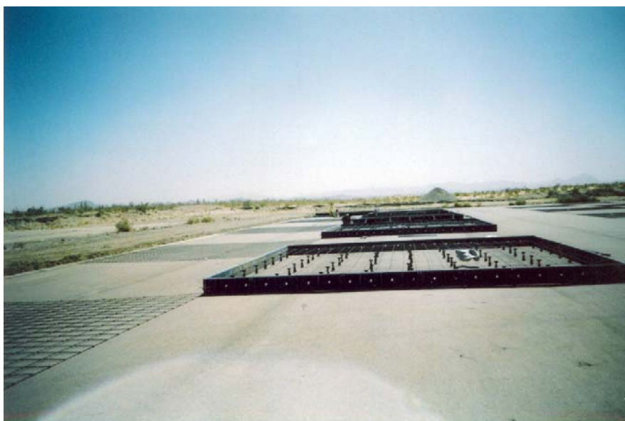
شکل ۱- قالب بندی و آرماتورگذاری یکی در میان دال های ۷.۵ در ۷.۵ متری بر روی آسفالت (سال ۸۵)
