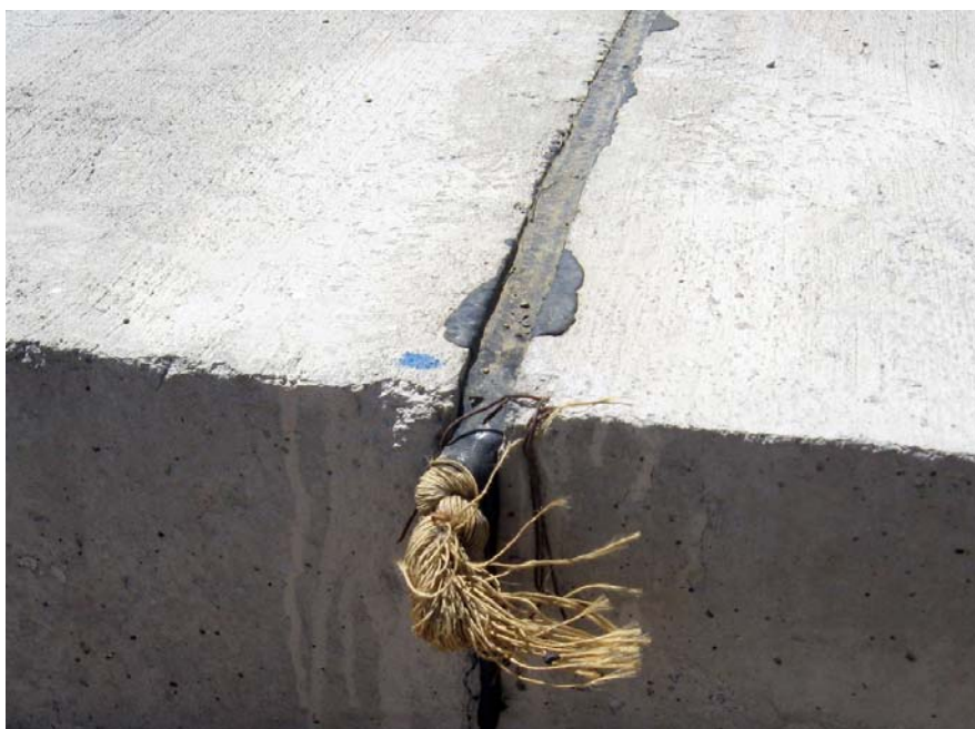
شکل ۸ - پر شدن نهایی درزهای اجرایی و انفضالی با رشته های کنفی و عایق های درزگیر پلیمری
