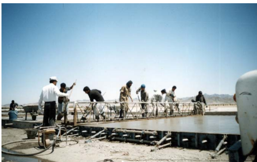
شکل ۴ - پرداخت رویه بتنی با روش سنتی ماله خربایبی در سال ۸۵
