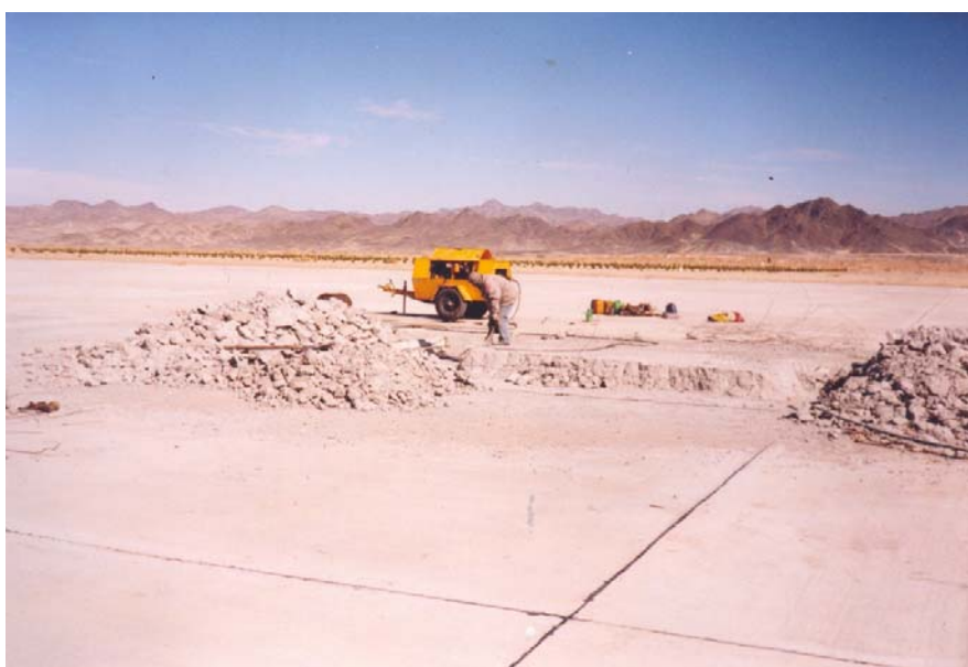
شکل ۶ - تخریب دال بتنی با کمپرسور و چکش بادی بواسطه نرسیدن مقاومت به مقاومت مشخصه
