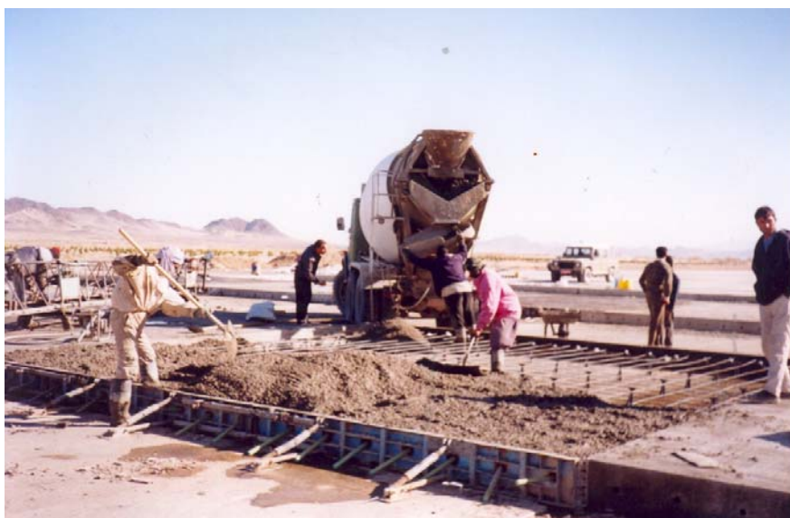
شکل ۳- روش قالب بندی و اجرای دستی (سنتی) در سال ۸۵
