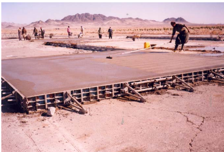
شکل ۵ - مضرس کردن دستی سطح دال بتنی در سنین اولیه با جاروی سیمی (روش سنتی)
