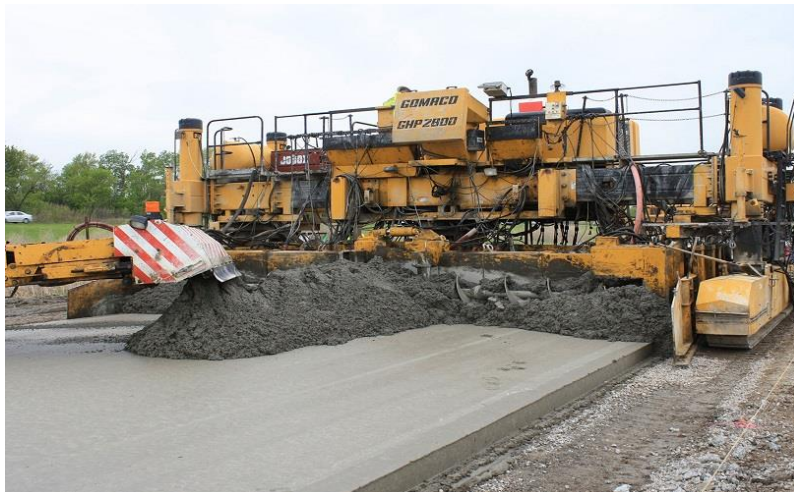
شکل ۲- اجرای روسازی بتنی
